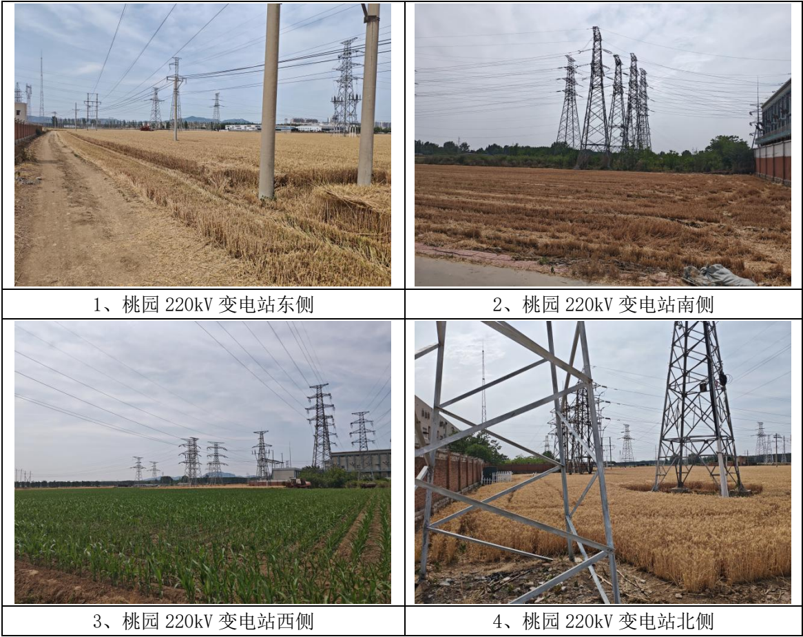
图 4-1 本工程变电站周围现场照片
