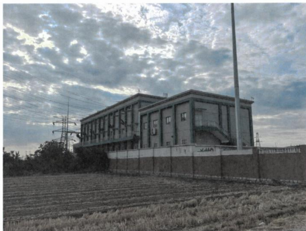
项目现场照片
