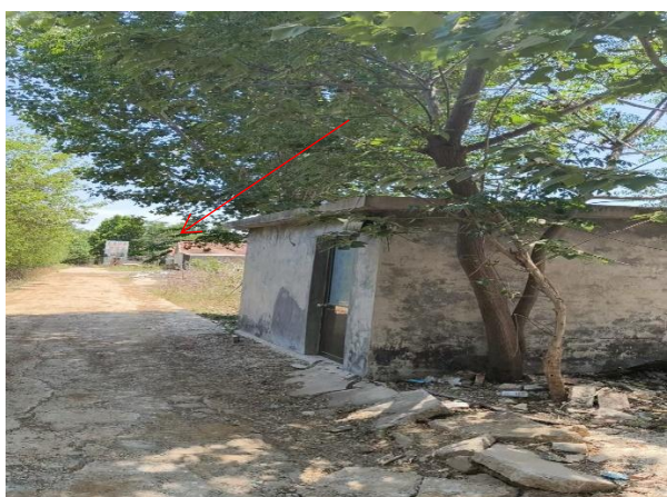
21. 110kV 红薛线 52#~110kV 曲薛线 38#杆塔跨越, 薛罗村东侧张丰炉具厂
