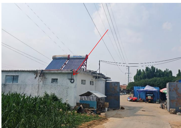
22. 110kV 红薛线 52#~110kV 曲薛线 38#杆塔边导线西侧 5m, 薛罗村东侧看护房
