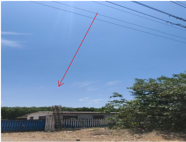
9. 110kV 红薛线 47#~48#杆塔边导线两侧 10m, 夏家村南苗木花卉培育基地
