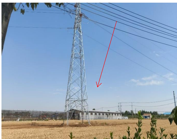
13. 110kV 红薛线时庄分支 8#~9#杆塔跨越，霍家村北工厂
