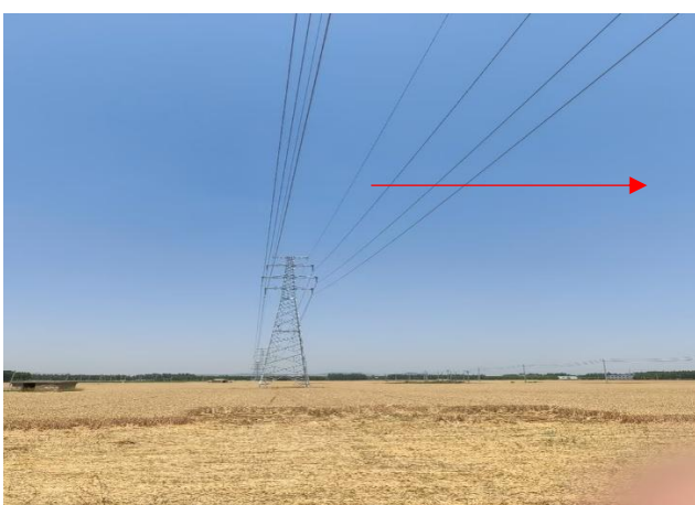
110kV红薛线43#塔~44#塔/110kV阜红线48#塔~47#塔双回架空线路东侧衰减
