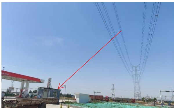
23. 220kV 电金线 6#~7#边导线西侧 15m, 霍家村西南侧看护房
