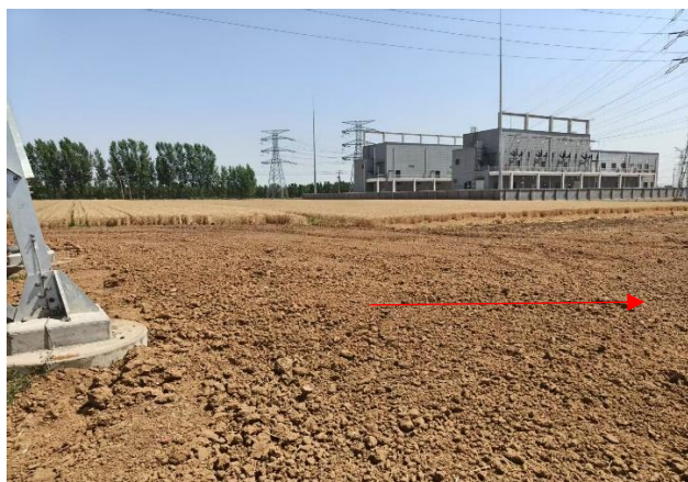
220kV红星站~110kV红薛线1#塔/110kV阜红线90#塔双回电缆东侧衰减
