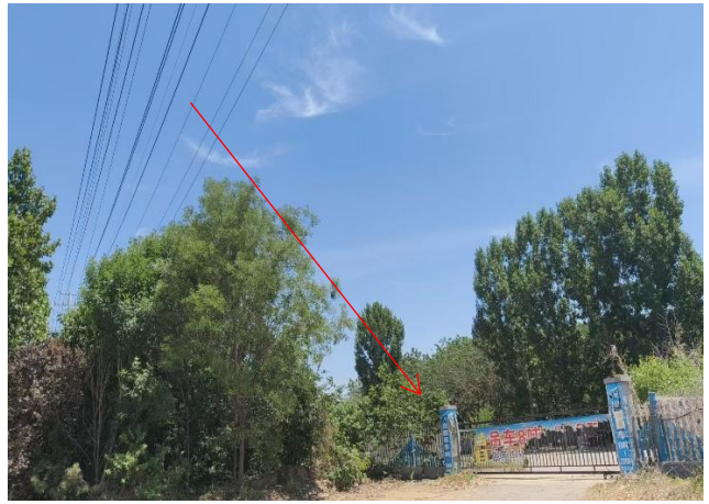
8. 110kV 红薛线 47#~48#杆塔边导线南侧 10m, 夏家村南汽车租赁公司
