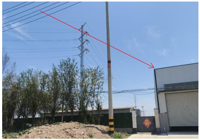
10. 110kV 红薛线 47#~48#杆塔跨越, 夏家村南厂房
