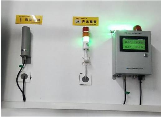
7、固定式剂量监测仪、声光报警仪、区域辐射监测仪
