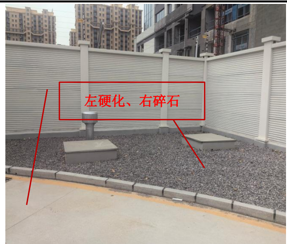
(8) 站内地面硬化及铺设碎石
