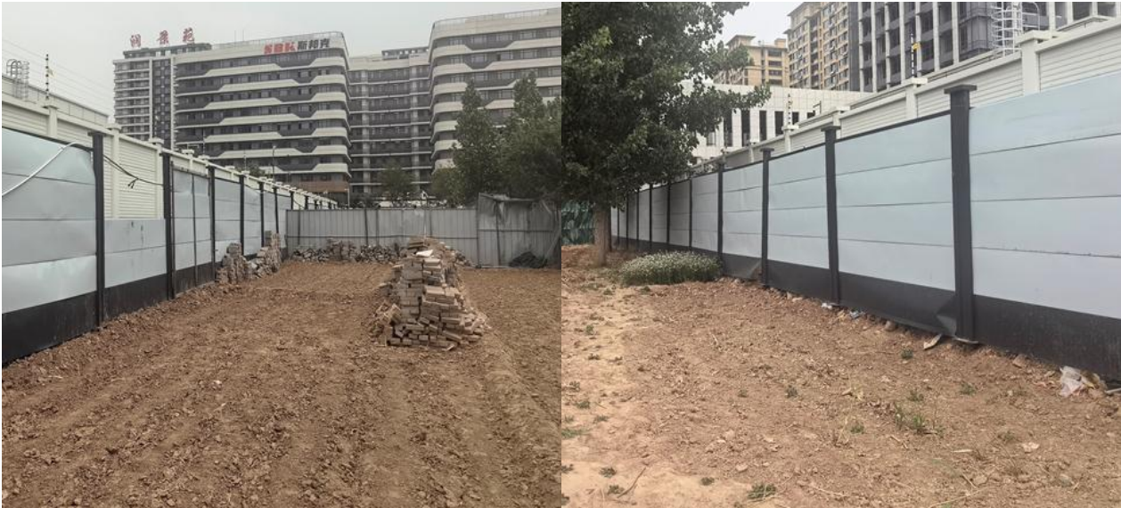
(1) 东侧配出工程施工区
