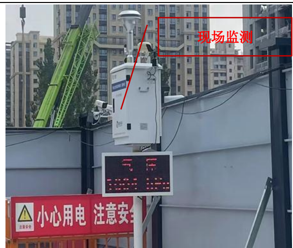
(12) 施工期现场监测
