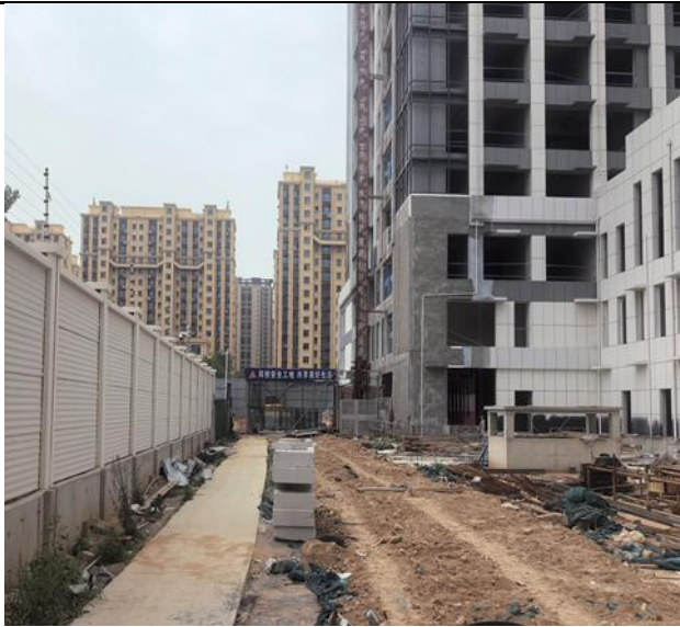
(3) 西侧温商大厦施工区
