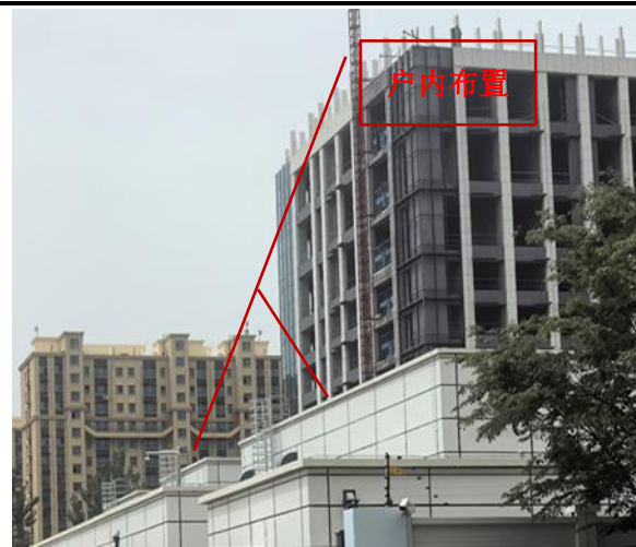
(7) 配电装置户内
