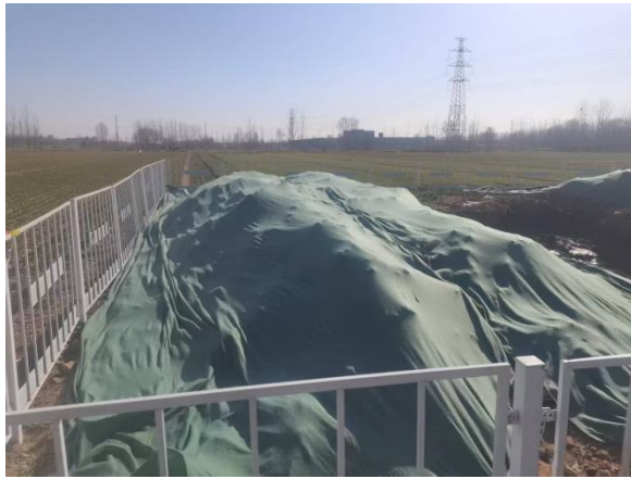
施工期土石方采用防尘网苫盖
