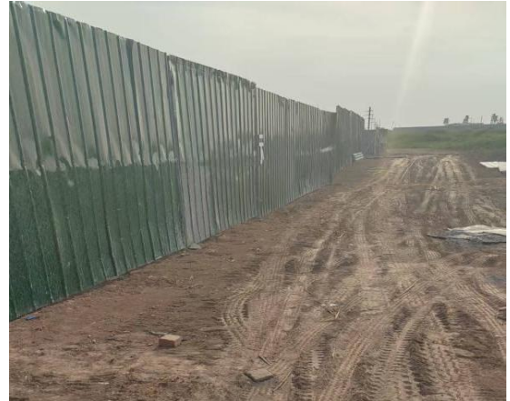
施工场地采用彩钢板进行拦挡
