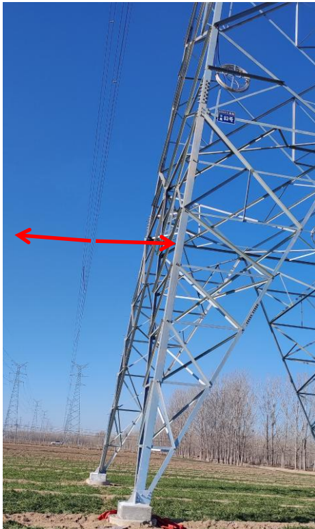
220kV 汇真线 83#~84#杆塔之间线路南、北 两侧衰减
