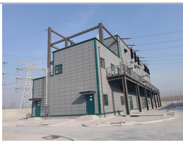
图 4-11 220kV 配电装置楼
