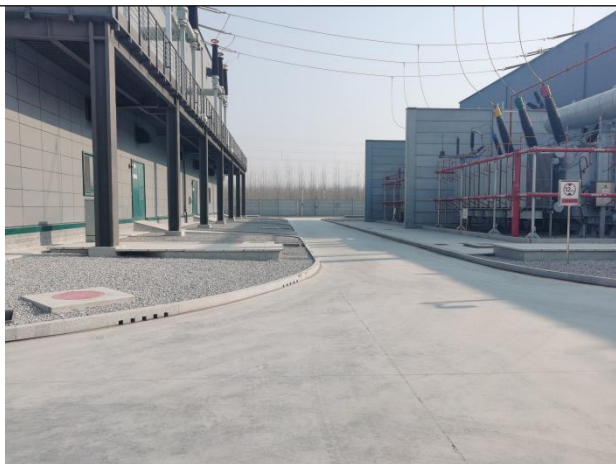
图 4-12 110kV 配电装置楼
