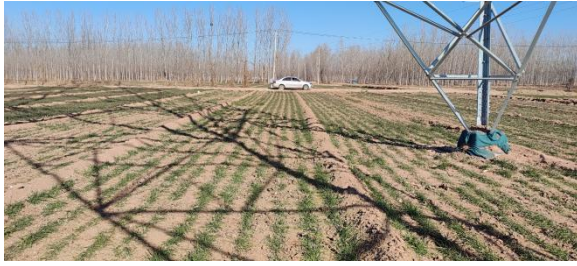
220kV 汇真线 79#临时施工道路恢复情况
